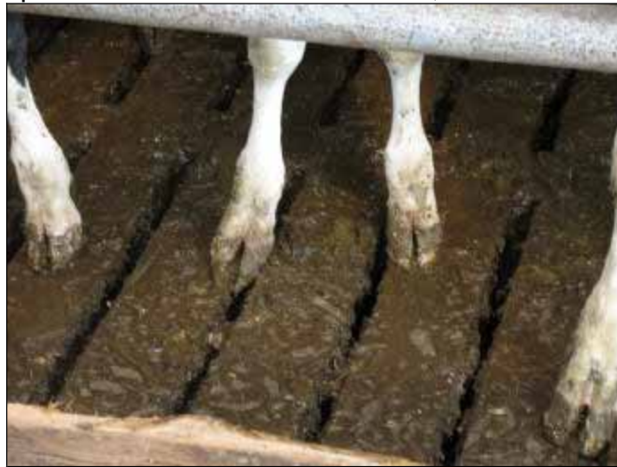
Bild 6: Zu weite Spalten stellen eine Verletzungsgefahr für die kleinen Kälberklauen dar.
